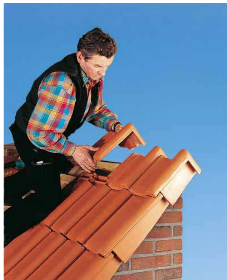
Montaż dachówki pulpitowej
